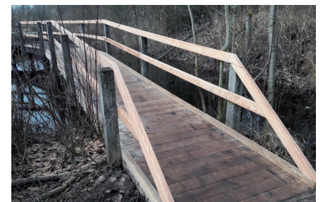
Renovation (1. Teil) des Holzsteges beim Hide «la Rainette» © Anna Lisa Mascitti
